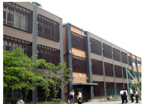
京都市立中京中学校 長寿命化（改修） R C造 地上3階建 / 京都市
