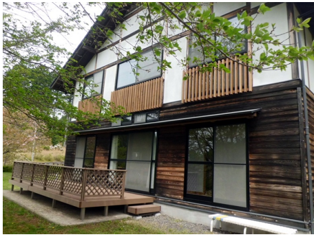
京北クラブハウス（改修） 木造 地上2階建 / 京都市
