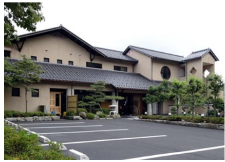
奥伊根温泉 油屋（改修） R C造 地上4階建 / 京都府与謝郡
