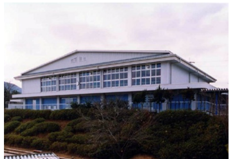
つつじヶ丘小学校 屋内運動場（改修） S造 平屋建 / 亀岡市
