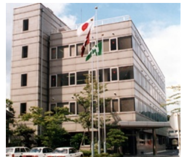
日進製作所 管理棟 S造 地上4階建 / 京丹後市
