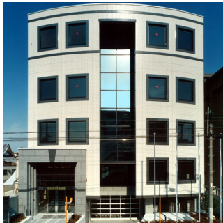
京都府不動産会館 RC造 地下1階地上4階建 / 京都市
