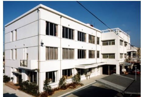
洛陽交運株式会社 社屋 RC造 地下1階地上3階建 / 京都市
