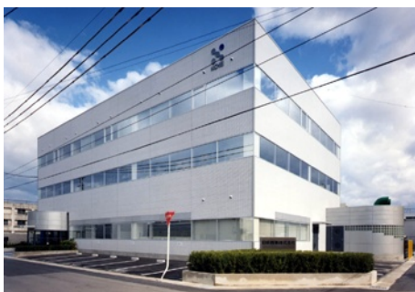
日栄商事 本社 社屋 S造 地上3階建 / 京都市
