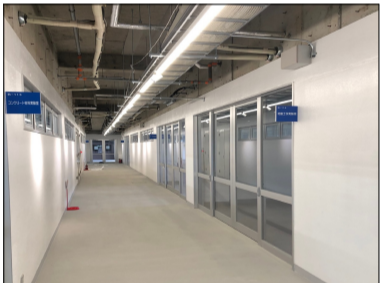
改修 実験棟廊下
