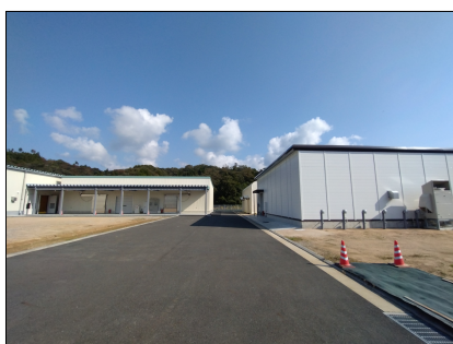
全景 貯蔵庫 (左) 冷凍庫 (右)
