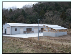
牛舎(奥)と堆肥舎(手前)間にパドック
