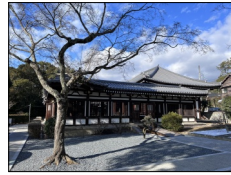
境内が整備された様子
