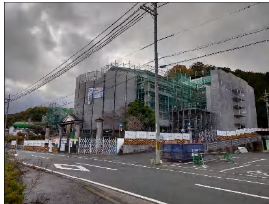
12月現在の外観 外壁の調査を行いました。
