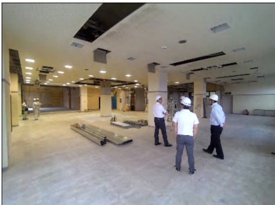
奥の厨房部分の壁も撤去し、広々としています。
