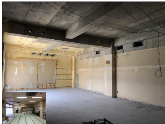
↑ 工事前の和室 和室の内装を撤去すると元のコンクリートが現れました。
