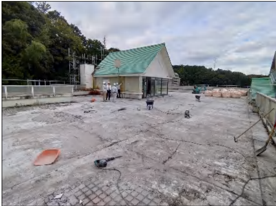
防水改修をします。 【3階レストラン】
