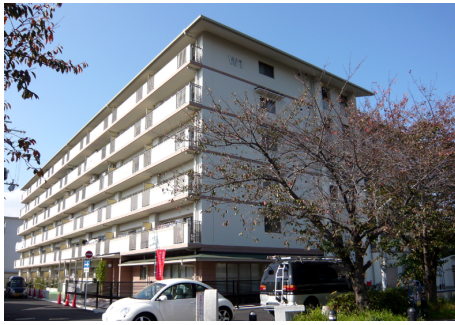
京都市崇人市営住宅屋形町 RC造 地上6階建 / 京都市
