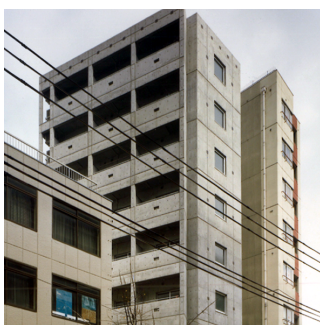
杉原ビル SRC造 地上9階建 / 大阪市
