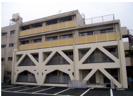
大阪国税局 深草第2寮 耐震補強 RC造 地上4階建 / 京都市
