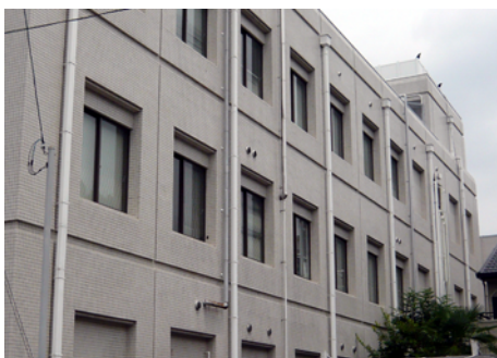
下京社会保険事務所 耐震補強 RC造 地上3階建 / 京都市
