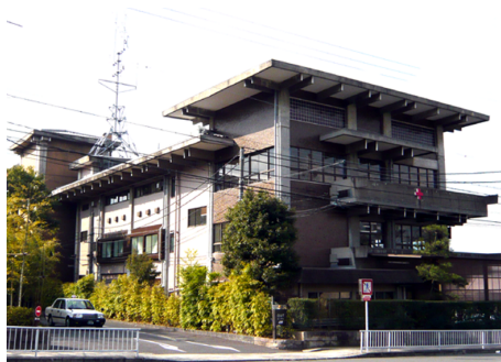
日本赤十字社京都府支部 耐震補強 RC造 地上3階建 / 京都市
