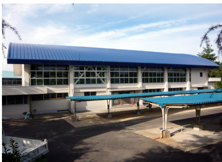
府立東宇治高等学校 体育館 耐震補強 RC造 地上2階建 / 宇治市
