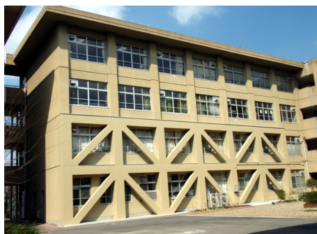
京田辺市立大住中学校 耐震補強 RC造 地上4階建 / 京田辺市
