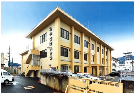
宮津警察署 耐震改修 RC造 地上3階建 / 宮津市
