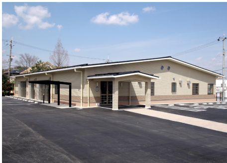
南つつじヶ丘コミュニティセンター S造 平屋建 / 亀岡市
