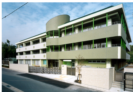
京都市大原野更生園 RC造 地上3階建 / 京都市
