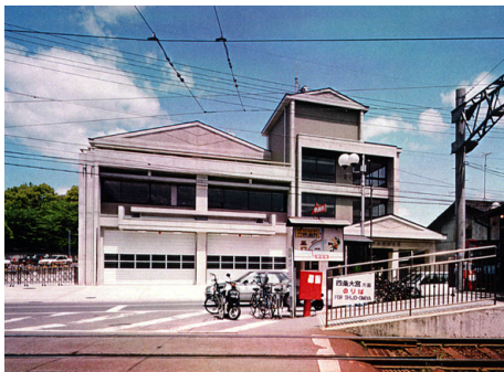
京都市右京消防署 RC造 地下1階地上3階建 / 京都市
