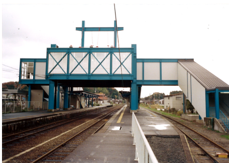
峰山駅 駅舎 S造 地上2階建 / 京丹後市
