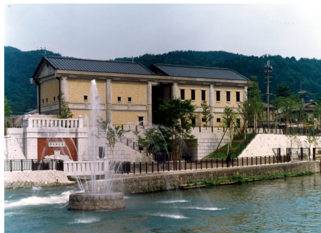
琵琶湖疎水記念館 RC造 地下1階地上2階建 / 京都市
