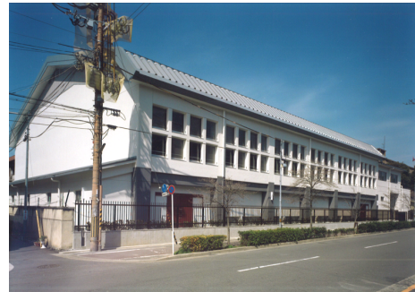
京都府立朱雀高等学校 体育館 R C造 地上2階建 / 京都市
