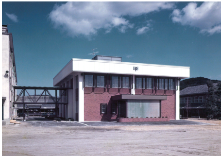
宇治田原町立維考館中学校 本館 R C造 地上2階建 / 京都府綴喜郡
