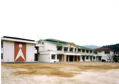
宇治田原小学校 校舎棟 R C造 地上3階建 / 京都府綴喜郡
