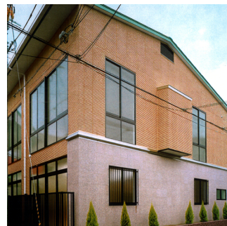
八条幼稚園 旧館 S造 地下1階地上2階建 / 京都市
