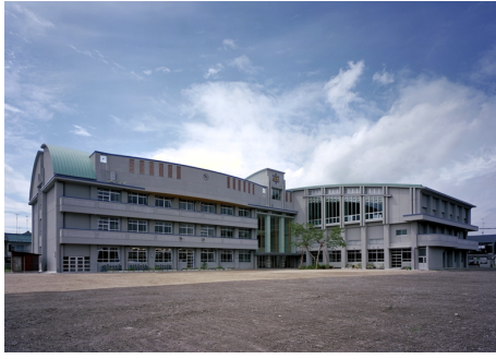
京都市立南大内小学校 総合校舎 R C造 地上4階建 / 京都市
