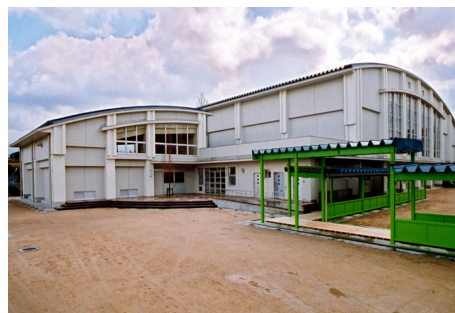
網野町立網野中学校 屋内運動場 RC+S造 平屋建 / 京丹後市
