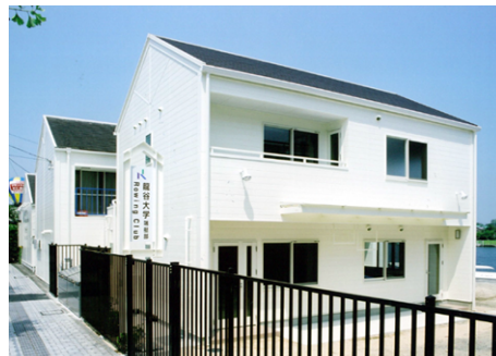
龍谷大学 艇庫 S造 地上2階建 / 滋賀県大津市
