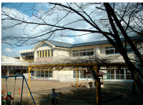
松井ヶ丘幼稚園 園舎(増築) R C造 地上2階建 / 京田辺市
